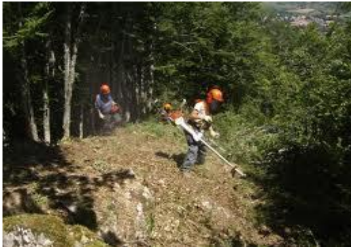
Débroussaillage des berges
