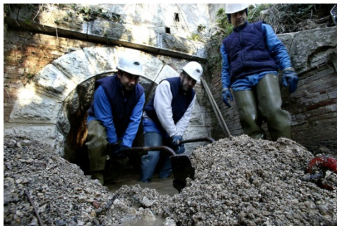
Curage d'un ouvrage
