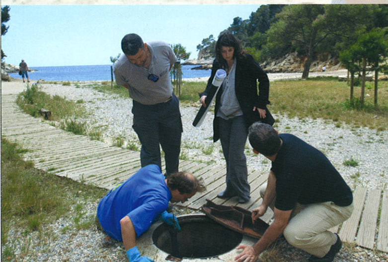
Examen de la fosse de la station de relevage de Port d'Alon, aux côtés de la Spgs et du Conservatoire du Littoral.
